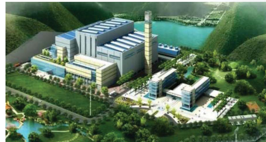
Usina de Tratamento Térmico (típica)
