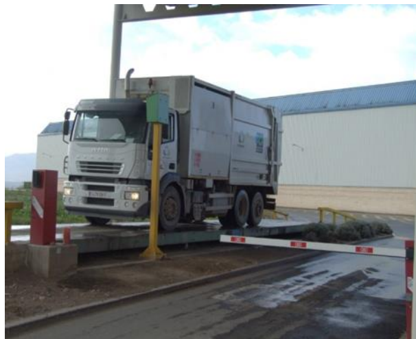
Figura 36 – Balança para pesagem dos caminhões (entrada à esquerda e saída à direita).
