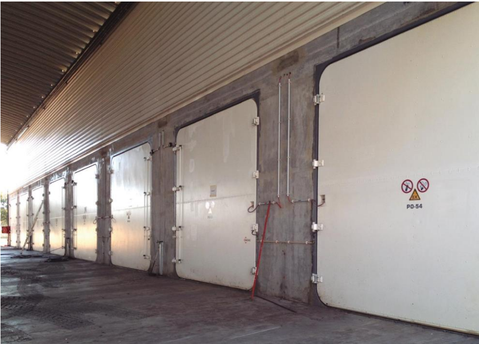
Figura 51 – Portas dos túneis de metanização.
