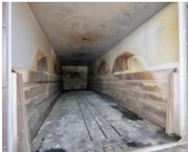
Figura 52 – Detalhe do interior do túnel.
