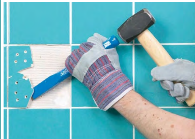
Reparo em Revestimentos
