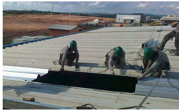
Reparo em Cobertura
