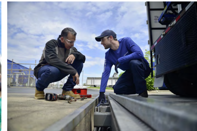
Manutenção de Balança
