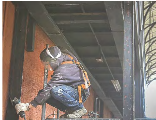
Reparo em Estrutura Metálica
