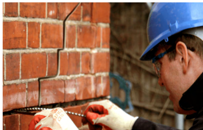
Reparos de Alvenaria e Estruturas de Concreto
