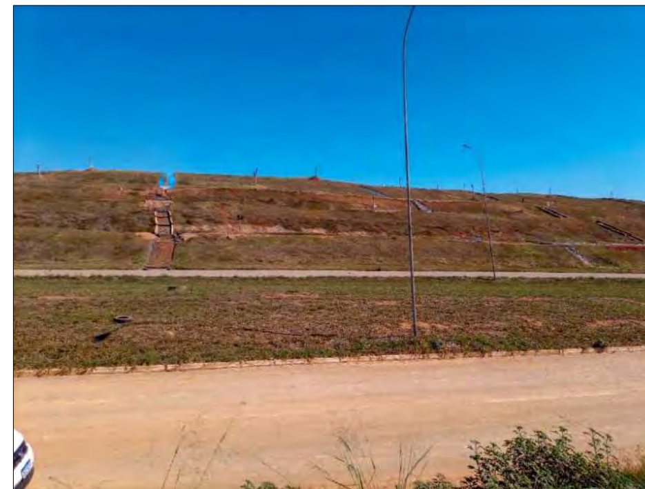
Taludes da Face Leste do Aterro
