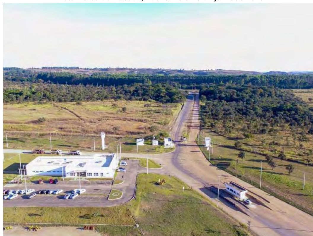
Vista Aérea do Acesso, Escritório e Balança Rodoviária
