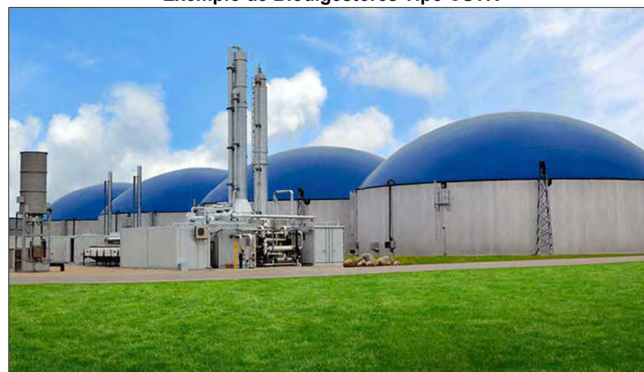
Exemplo de Biodigestores Tipo CSTR
