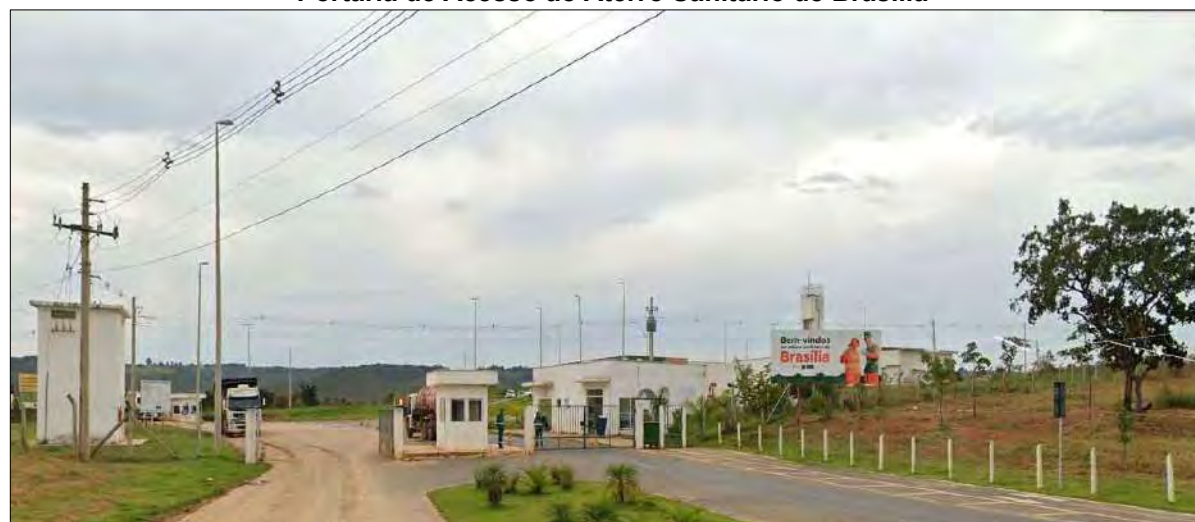
Portaria de Acesso ao Aterro Sanitário de Brasília
