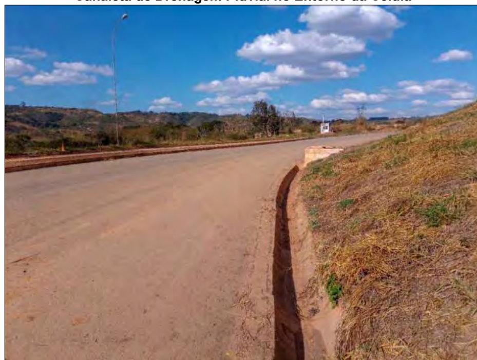
Canaleta de Drenagem Pluvial no Entorno da Célula
